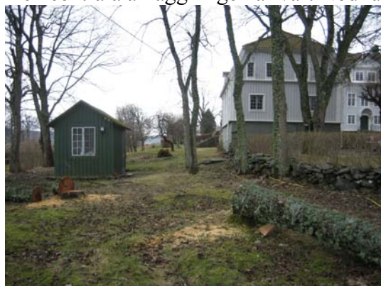
Nodhuset sett från Norr.
