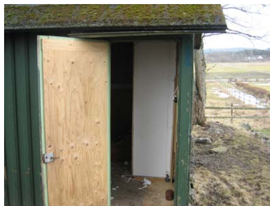
Invändigt är routrarna inbyggda i ett hopskruvat skåp.
